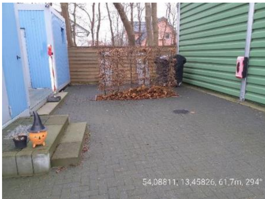
Abbildung 9: Pflasterung zwischen Sanitärcontainer und Lagerhalle
