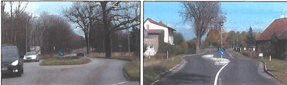
Abb. 6 Beispiele Ortseingangsgestaltung mit Fahrstreifenversatz
